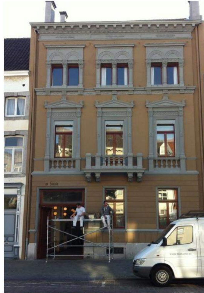
Fig. 5. Voorbeeld van het resultaat van een verkennend kleuronderzoek. De gevel wordt opnieuw in de teruggevonden 'oude' kleurstelling geschilderd.
