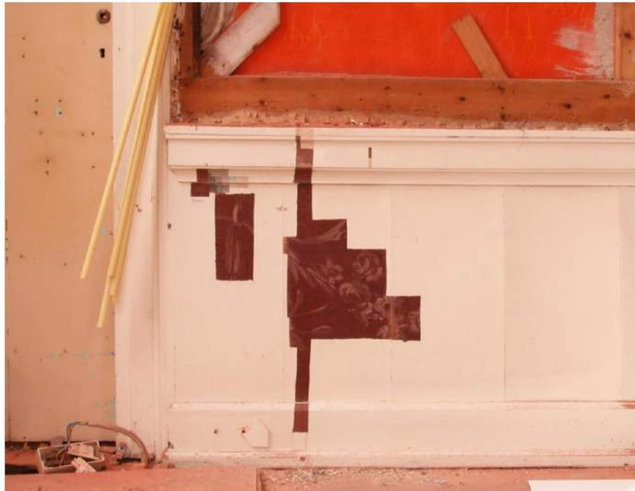
Fig. 9. De Trompenburg te 's-Graveland. De vlakke houten lambrisering in de voorkamer werd bij het bouwhistorisch onderzoek geduid als afkomstig uit de 18 de eeuw. Linksboven is een punctie op de buiklijst gemaakt (tijdens een eerste inventarisatie). Bij het verkennend kleuronderzoek is een kleurentrap vervaardigd (rechtsboven) naar aanleiding daarvan is een groot venster van de rode afwerking vrijgelegd, waarbij ontdekt werd dat de schilderijen op de lambrisering uit de bouwtijd (1675) van het huis stammen.
