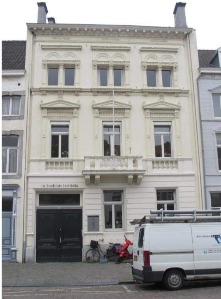
Fig. 5. Voorbeeld van het resultaat van een verkennend kleuronderzoek. De gevel wordt opnieuw in de teruggevonden 'oude' kleurstelling geschilderd.
