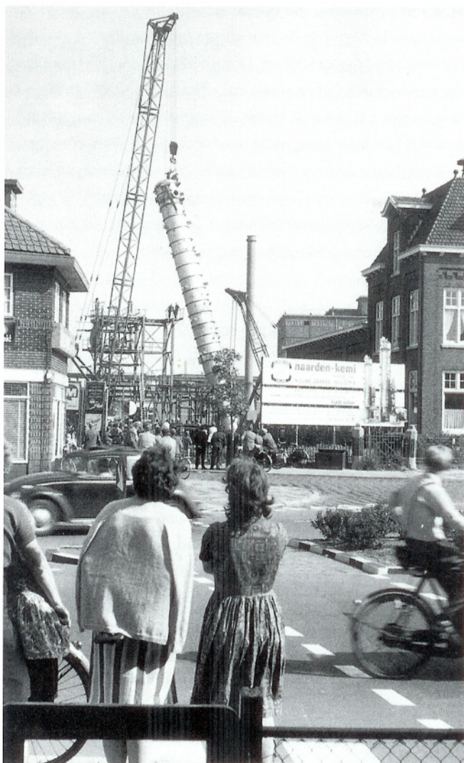
Het gehele volk keek vol verwachting toe hoe Nederland industrialiseerde. In 1964 bouwde de engineering contractor Foster Wheeler voor Naarden Kemi (een joint venture van de fa. Jan Dekker en de Chemische Fabriek 'Naarden') in Wormerveer een destillatie-installatie voor vetzuren. Kort na de ingebruikneming sloeg de stemming om. Voortdurend klaagden de omwonenden
