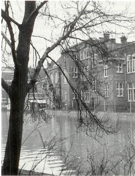
Fig. 4. Het Laboratorium voor Chemische Technologie van de Universiteit van Amsterdam aan de Plantage Muidergracht. Links de voormalige Boekmanschool, rechts de voormalige Burgerschool. Het gehele complex begin 1985 gesloopt.
