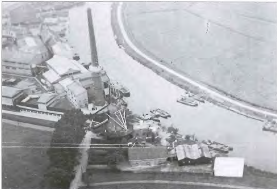
Een luchtfoto van de Nederlandse Kininefabriek in de jaren dertig. Aan de Vechtzijde oefent de Genie. Zij bouwen een pontonbrug.
