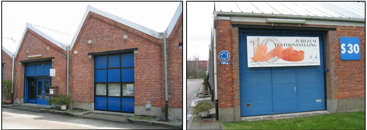
Figuur 17: De loodsen op de Campus Sterre die gerenoveerd werden en waar momenteel het Museum voor de Geschiedenis van de Wetenschappen is in ondergebracht. De eerder sombere buitenzijde staat in schril contrast met de pracht van de collecties binnenin.
