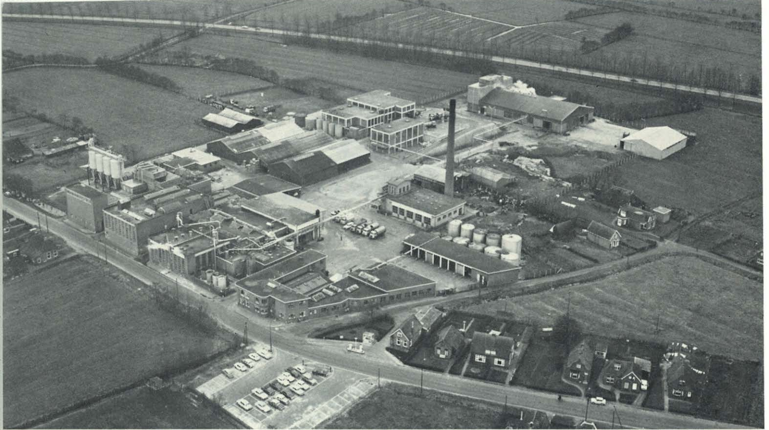
Overzichtsfoto Ned. Thermochemische Fabrieken, Bergum
