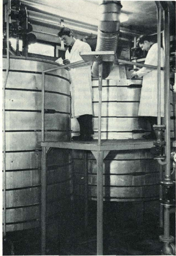
Kuipen voor het vervaardigen van kleurstoffen bij de Nederlandse Kleurstofindustrie.
